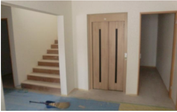
1階エレベーター (3人乗り)
